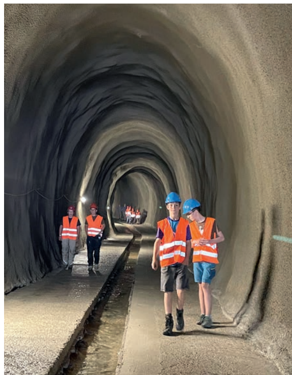
Eindrückliche (und buchstäblich coole) Besichtigung des Fluchtstollens.
